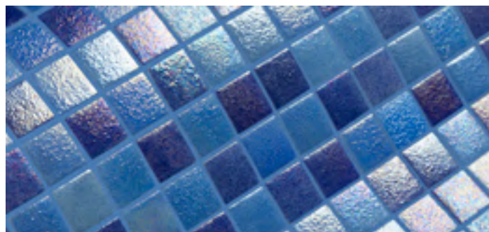
Junta azul. // Blue grouting
